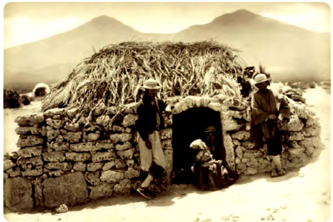
▲ Vivienda quechua (Zona Norte), hace más de 100 años. En su construcción se utilizaron rocas apiladas, paja y madera.
